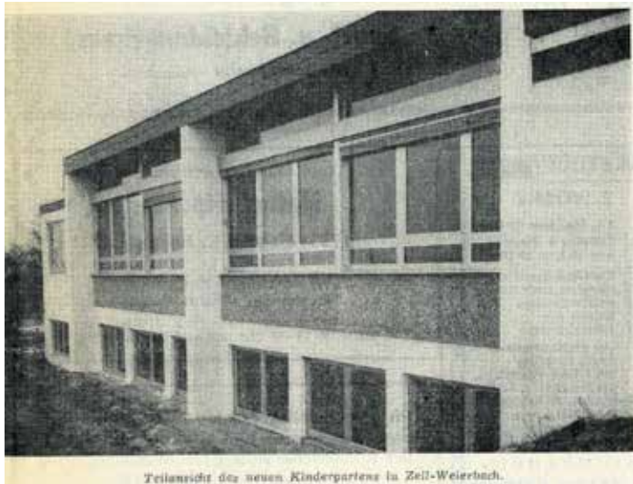
Teilansicht des neuen Kindergartens in Zell-Weierbach.
