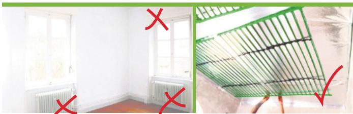
Mit wasserführenden Kapillarnetzen
